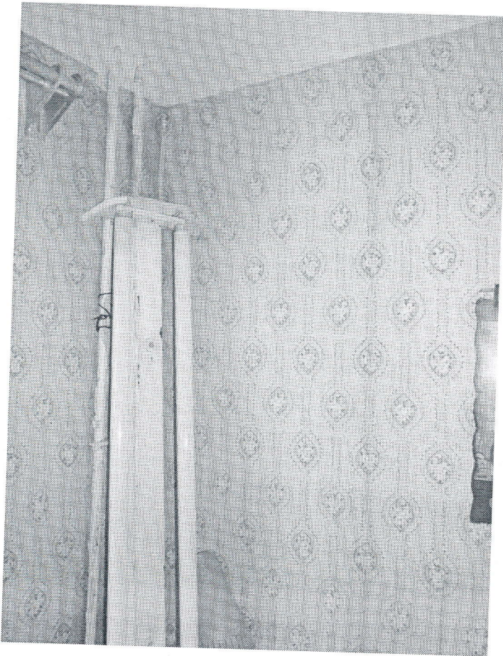
Фото №10. Угловая комната. Отслоение, вздутие окрасочного слоя потолка помещения.
