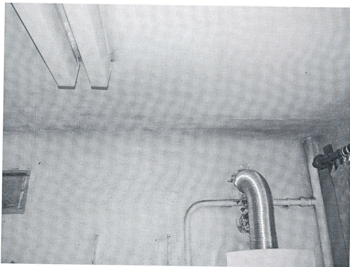
Фото №14. Кухня. Желтые пятна на отделочном слое потолка и стен.
