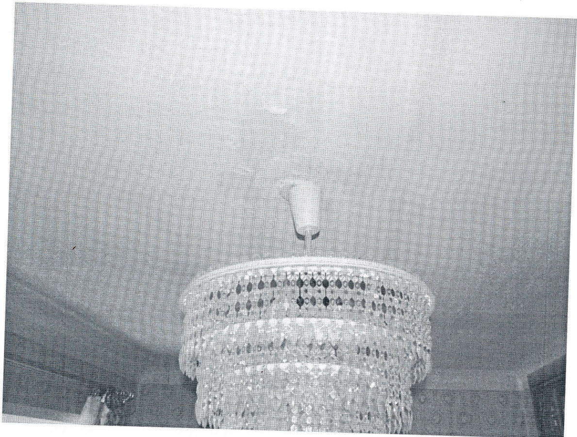
Фото №10. Угловая комната. Отслоение, вздутие окрасочного слоя потолка помещения.
