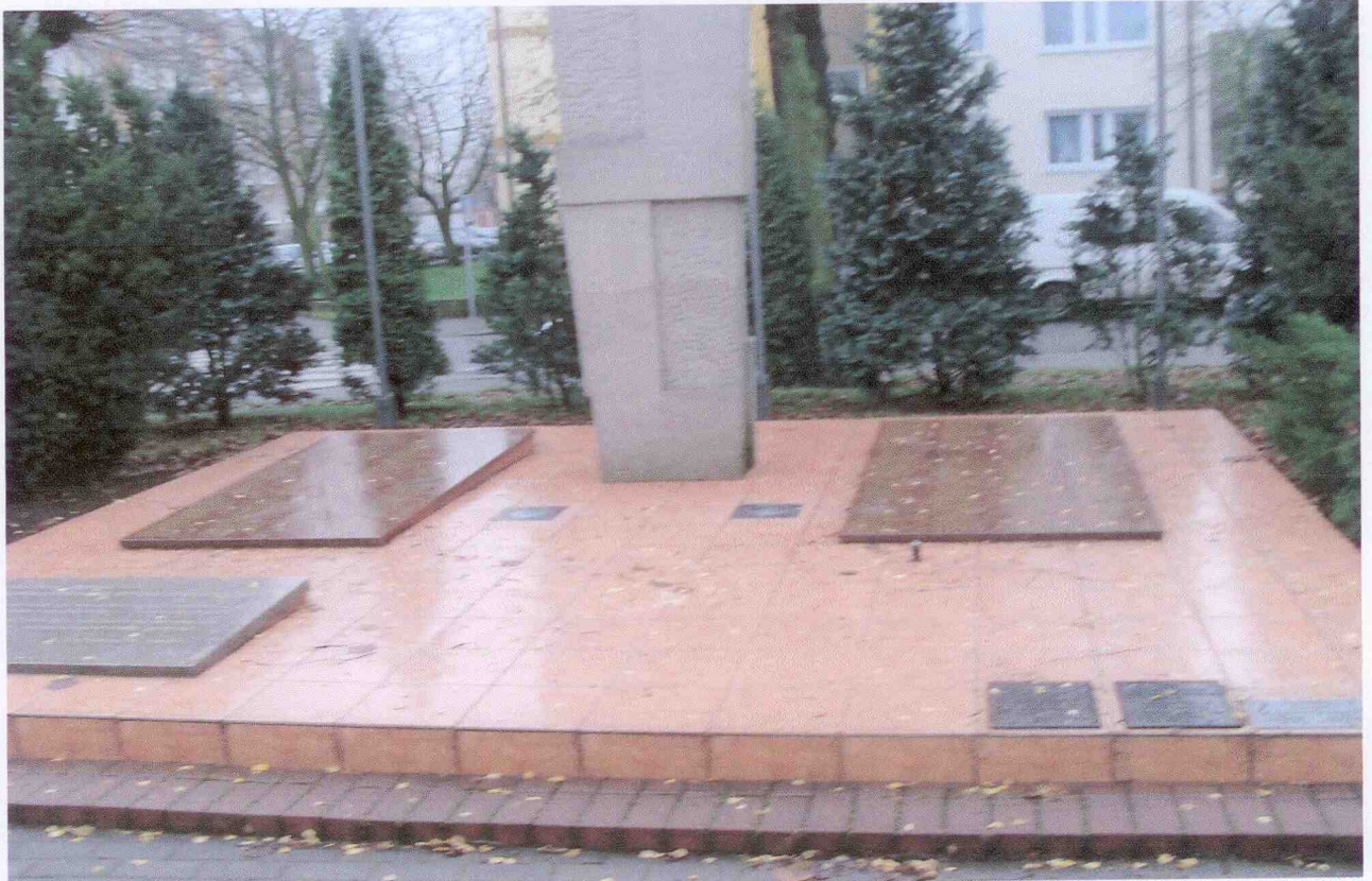
Widok ogólny na płyty przed wykonaniem prac
