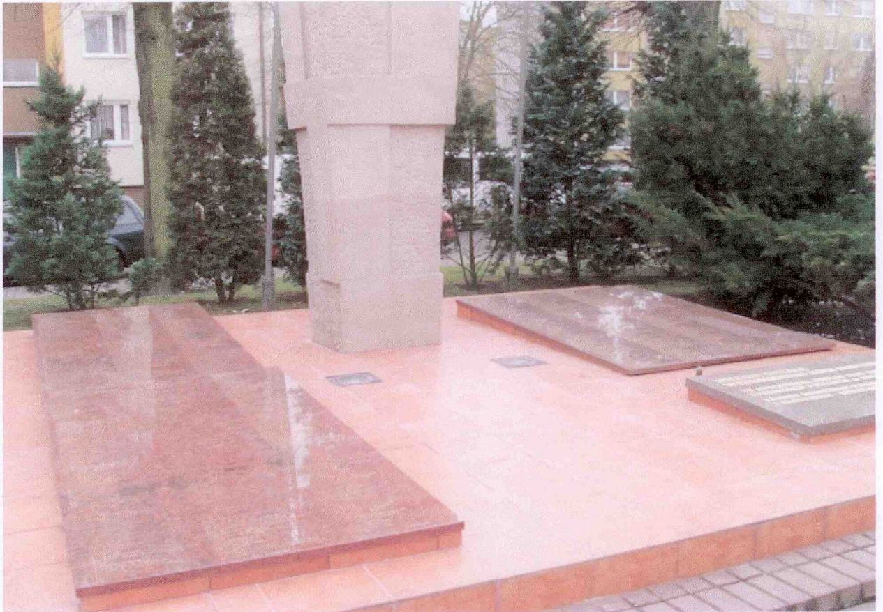
Zdjęcie po wykonaniu prac tj. po zamontowaniu 3 płyt granitowych z pełnymi nazwiskami żołnierzy oraz widoczna z prawej strony odnowiona płyta pamiątkowa
