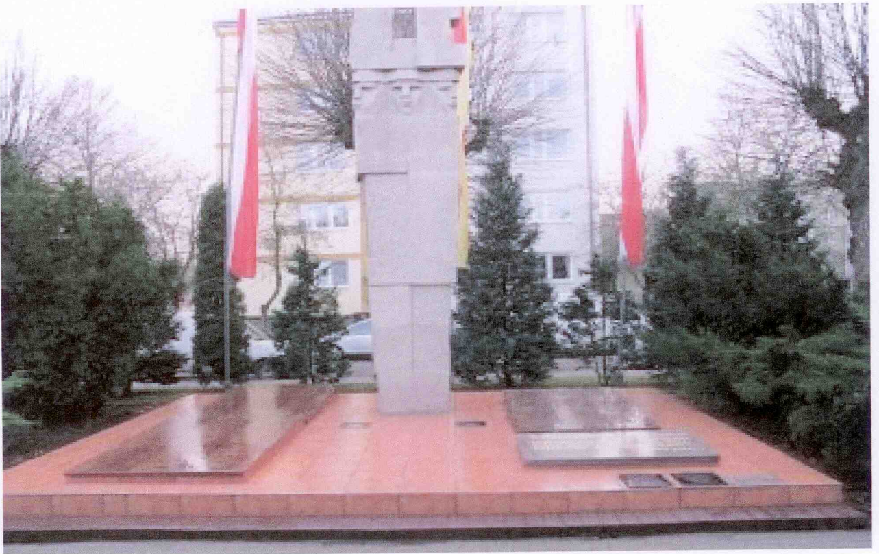
Zdjęcie po wykonaniu prac tj. po zamontowaniu 3 płyt granitowych z pełnymi nazwiskami żołnierzy oraz zamontowane flag. Widoczny oczyszczony postument pomnika z piaskowca.
