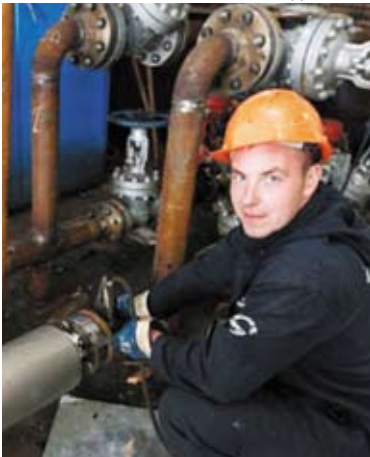
Монтаж массового расходомера ведет машинист технологических насосов Андрей Асташкевич
