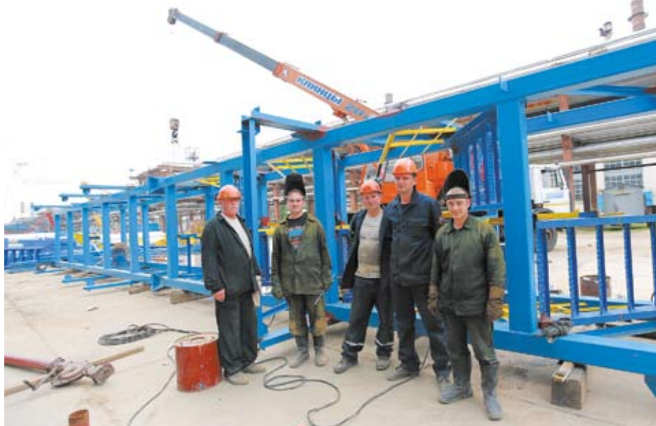
Укрупнение металлоконструкций ведут монтажники минского ОАО «Промтехмонтаж»
