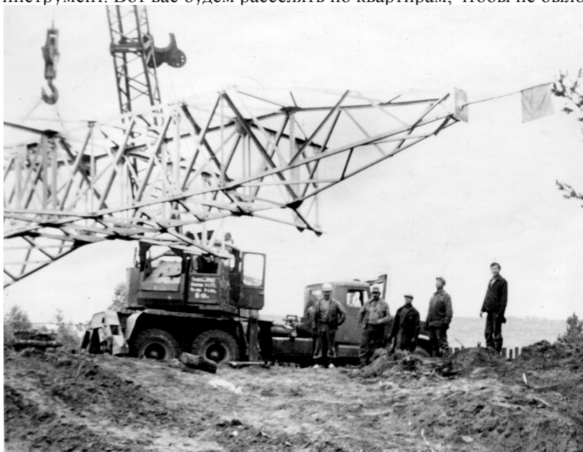
Установка опоры ЛЭП. А.Е. Фильковский 2-ой справа
