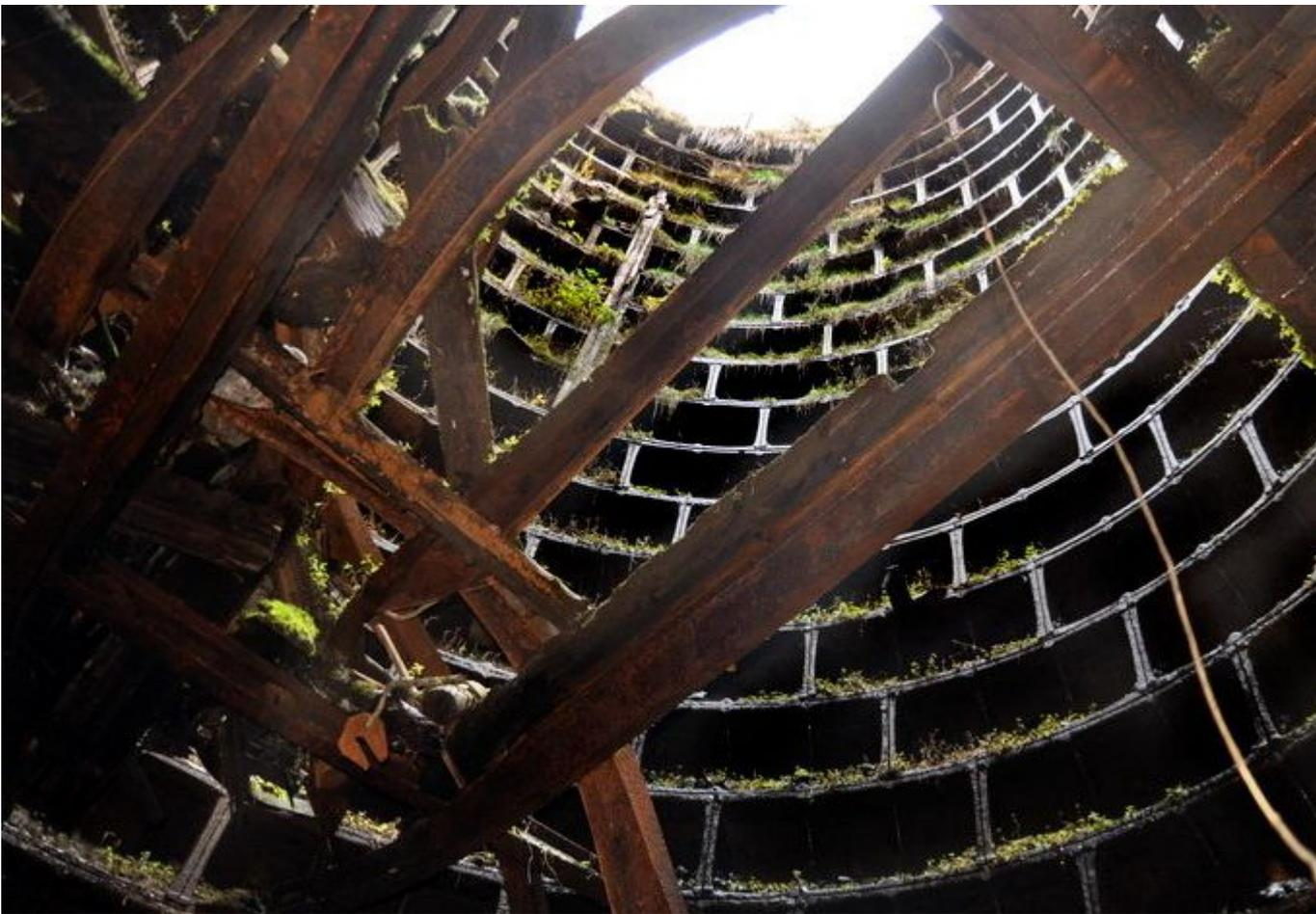
*В свободном доступе лишь верхние 20 с небольшим метров. Далее идёт пласт захламления грунтом и деревянно-металлическим мусором, покоящийся на ледяной подушке. Сохранились вертикально идущие трубы водоотлива, а так же, фрагментарно, изоляторы электроснабжения*
