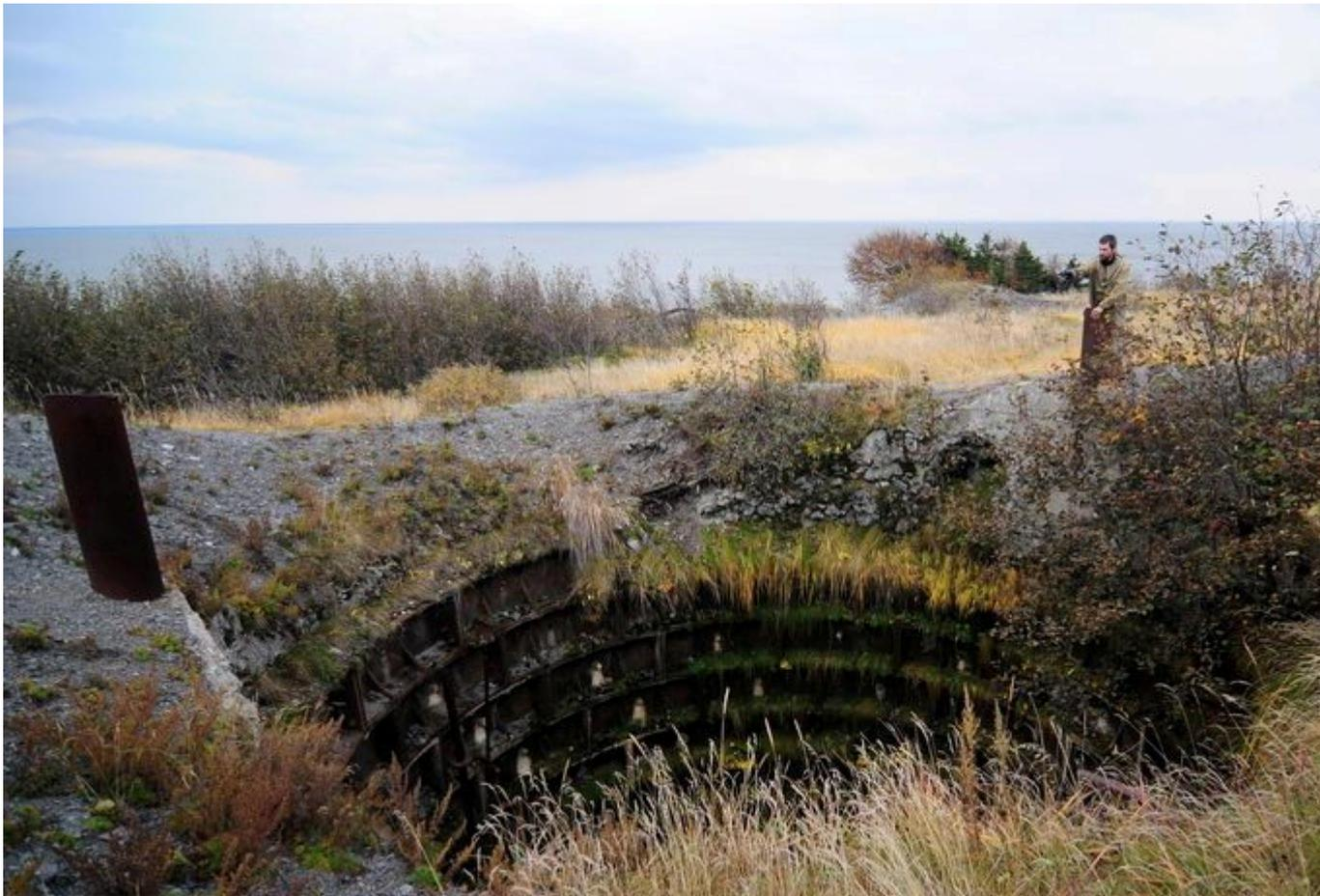
*Глубина порядка 55 метров, диаметр около 9 метров, ствол забетонирован и облицован чугунными тубингами, крепящимися друг к другу двенадцатью болтами.*
