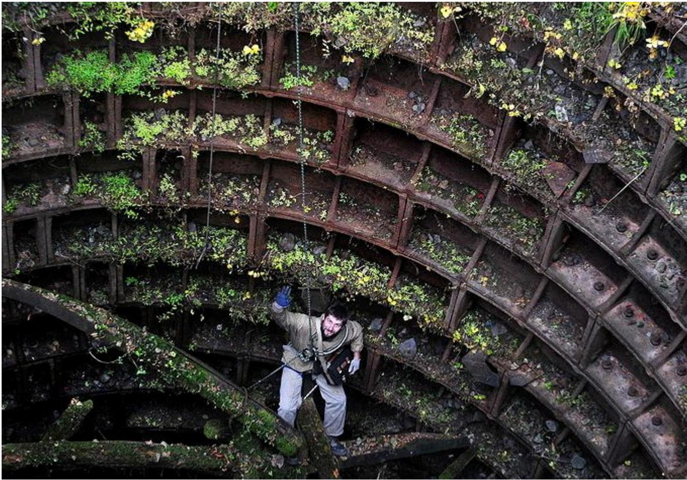
*Вес каждого тубинга 300 кг, на всех маркировка "ЭН 5" и номера*
