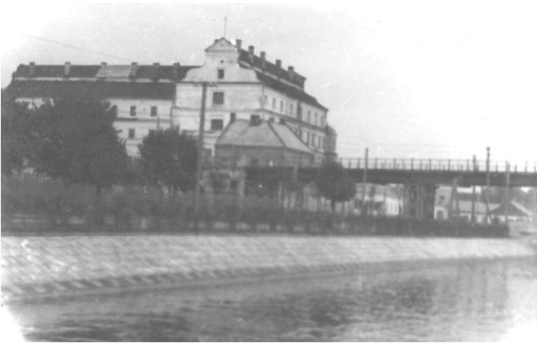
Фото 51 Пинск. Здание штаба Флотилии и мост через р. Пина.
