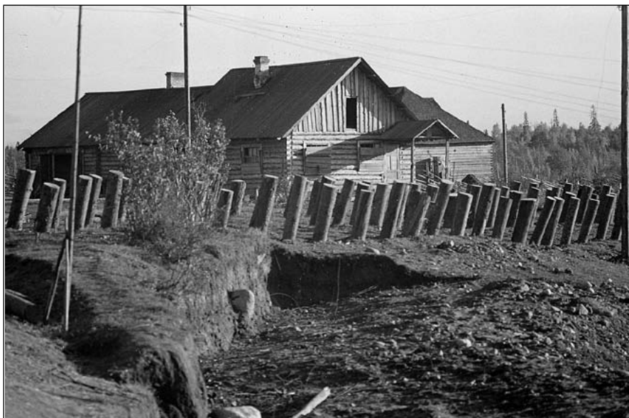
Противотанковый эскарп и надолбы в посёлке Вилга 19 сентября 1941 года ( http://sa-kuva.fi/neo )
