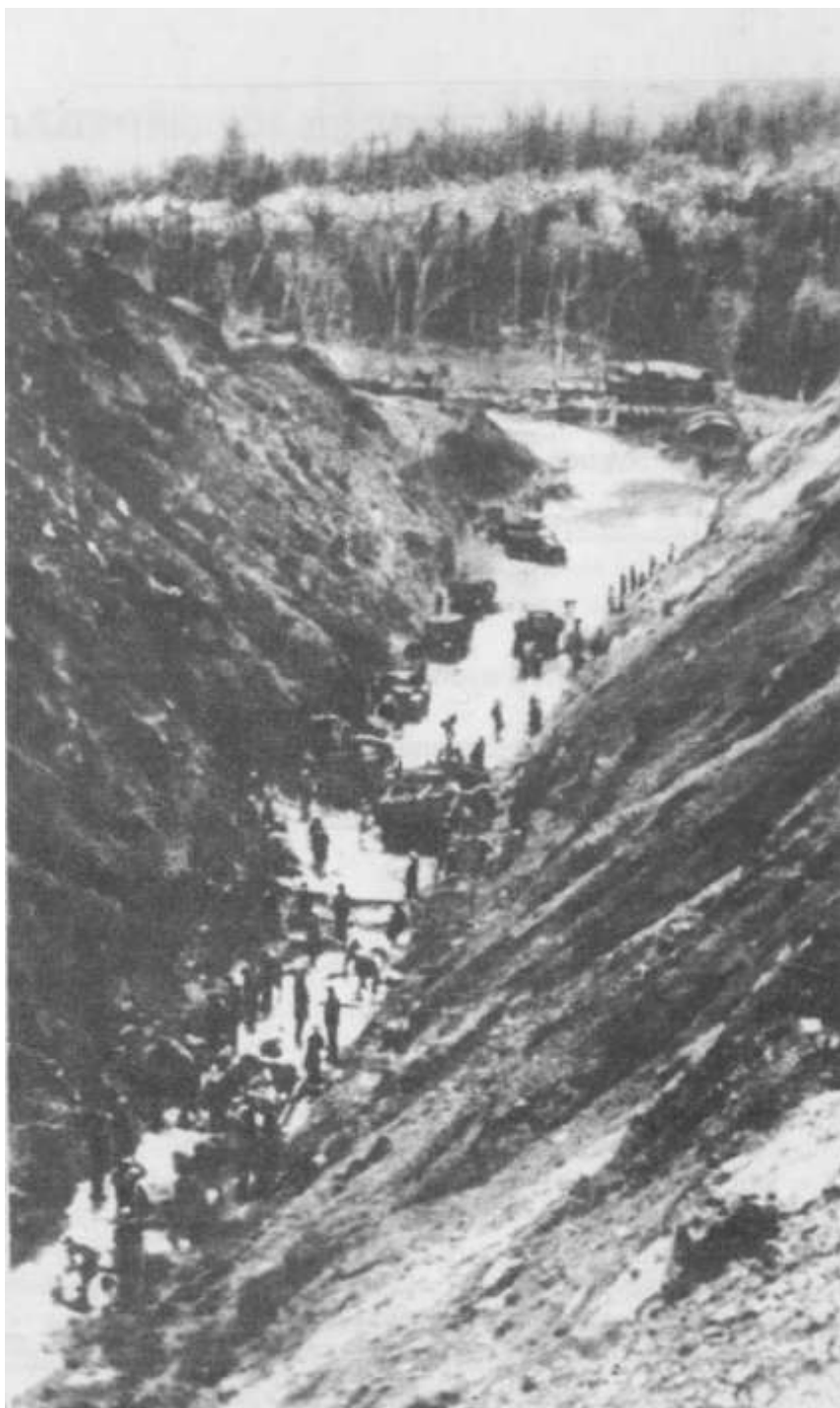
Работы в выемке
