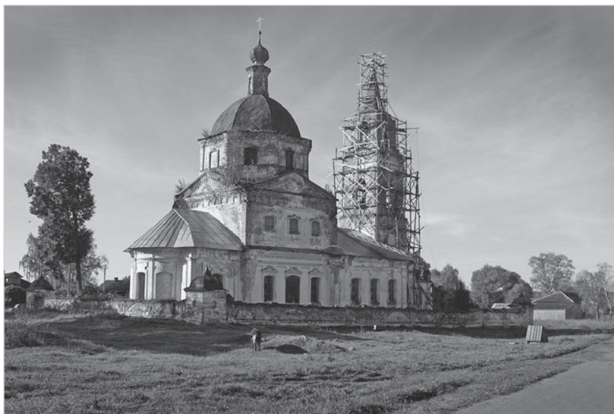
Ил. 14. Церковь Сергия Радонежского с. Мосейцево Ростовского р-на Ярославской обл. 2006 г. Вид с северо-востока. Фото Алексея В. Киселёва
