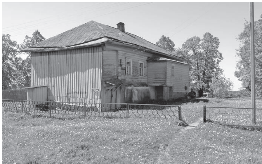
Ил. 9. Здание почтового отделения в с. Мосейцево Ростовского р-на Ярославской обл. Вид с северо-востока. Ранее — жилой дом крестьян Ивановых. 2010 г. Фото Алексея В. Киселёва
