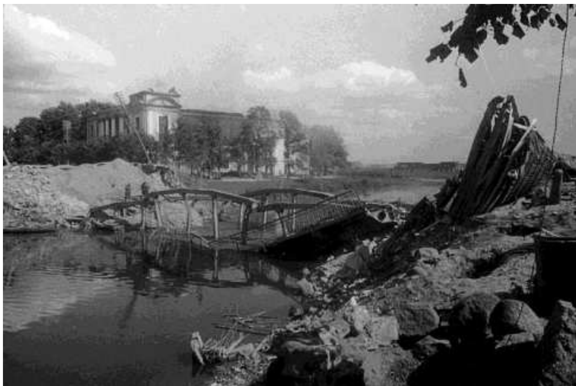
Разрушенный мост через реку Лиелупе, 1 августа 1944 года
